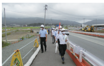
工事中の国道を歩いている避難
