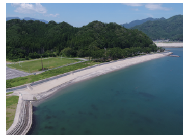
工事完了後の根浜海岸
