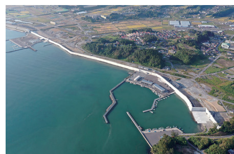
脇之沢漁港海岸防潮堤(写真提供:陸前高田市)
